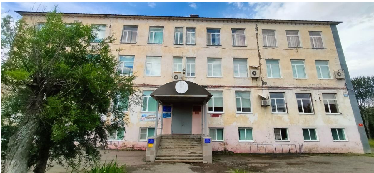
Фото 2. Общий вид на здание, расположенное по адресу: г. Вилючинск, ул. Мира, д. 19 (ракурс 2).
