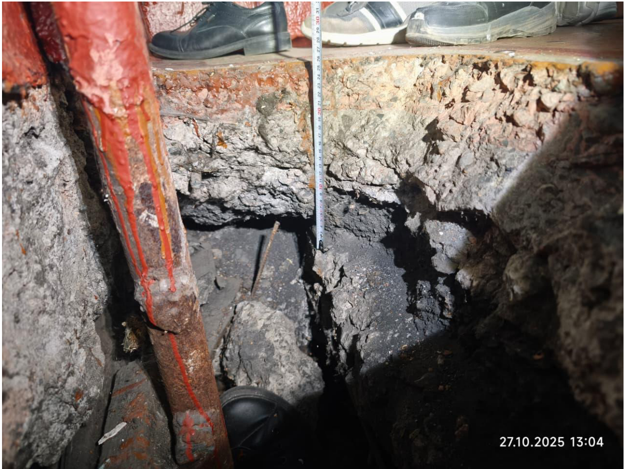
Фото 7. Толщина конструкций пола на 1-ом этаже.
