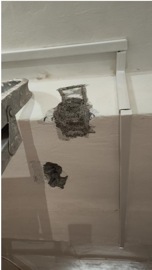
Фото 15. Определение арматуры балок
