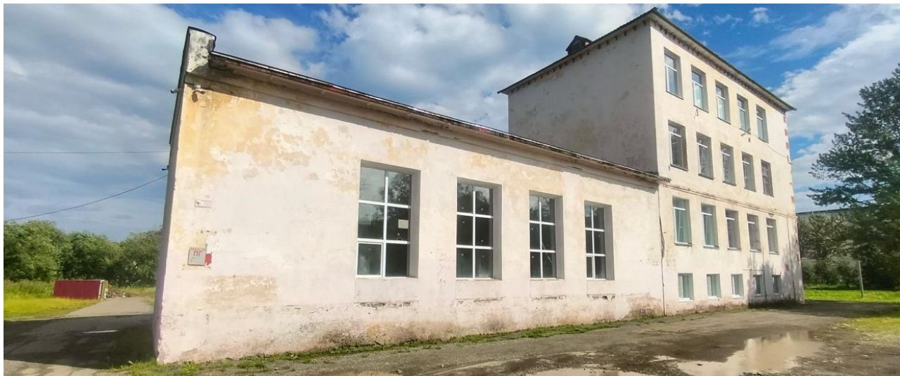
Фото 2 Общий вид на здание, расположенное по адресу: г. Вилючинск, ул. Мира, д. 19 (ракурс 1).
