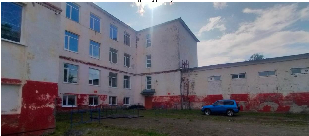
Фото 4 Общий вид на здание, расположенное по адресу: г. Вилючинск, ул. Мира, д. 19 (ракурс 3).
